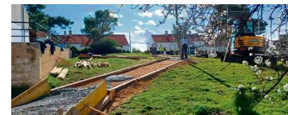
**ZAPOČELI SU RADOVI NA sanaciji pješačke betonske staze na Gorici svetoga Vlaha, u neposrednoj blizini igrališta. Sanacija obuhvaća uklanjanje postojeće oštećene staze, pripremu terena, izgradnju nove pješačke staze i betonskih skalina, kao i dodatnu sanaciju nogostupa i betoniranje prilazne uzbrdice u blizini radova.**
