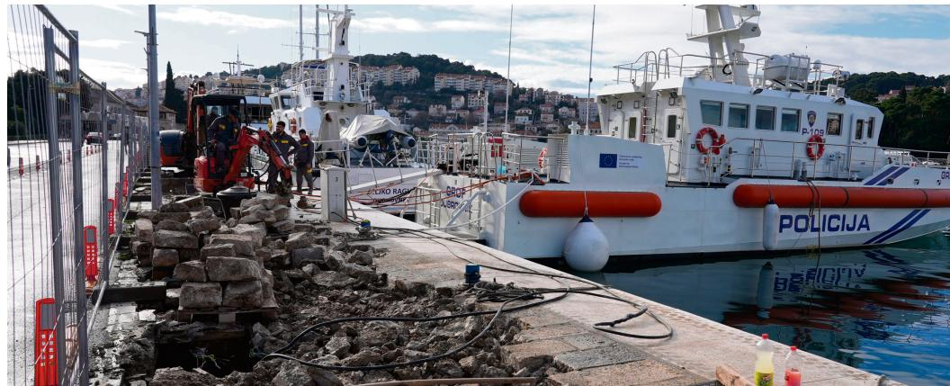
**ZAPOČELO JE UKLANJANJE KAMENE obloge na obalnoj šetnici na dijelu od Place do mula Petka, u okviru radova na uređenju budućeg drvoreda u Gružu. Nakon uklanjanja podne obloge najprije će se napraviti iskop kao**
