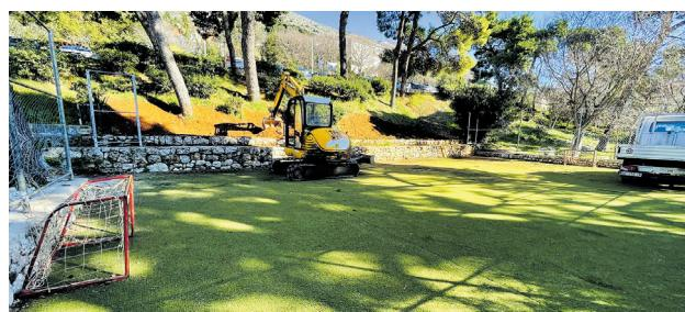
ZAPOČELI SU RADOVI SANACIJE sportskog terena 'Šumica' u Ulici Andrije Hebranga. Planirani radovi uključuju izradu tzv. parapetnog zida na sjevernoj strani igrališta, iznad tribina, radi sprečavanja prodora bujica vode na teren, uklanjanje dotrajale umjetne trave i zamjena s novim slojem asfalta, postavljanje novih barica za mali nogomet, iscrtanje terena te sanaciju oštećenja na ogradama. Radovi se izvode u sklopu redovnog održavanja sportskih igrališta, a ugovoren izvođač je Tehnogradnja d.o.o.
