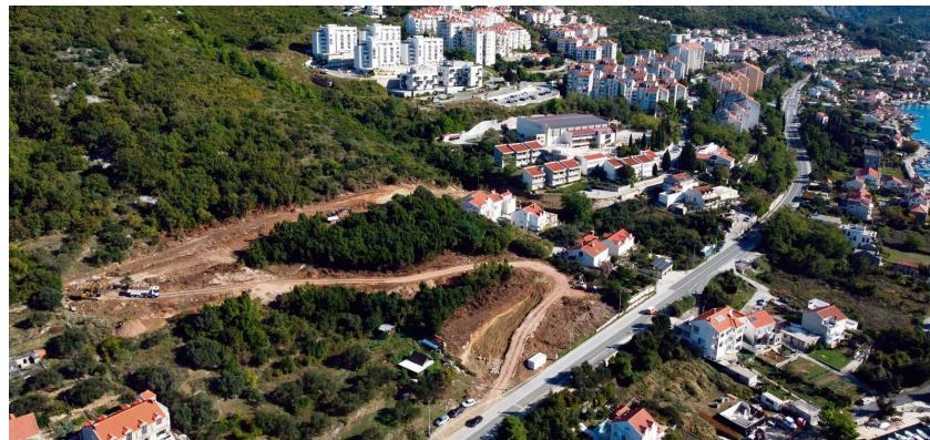
MJESEC DANA NAKON POČETKA izvođenja, radovi na izgradnji dvosmjerne spojne ceste Tamarić koja će uvelike unaprijediti funkcionalnost cestovne mreže Nove Mokošice, napreduju sukladno planiranoj dinamici, a na gradilištu je u tijeku izvođenje zemljanih radova i potpornih zidova.
