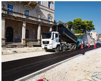
sloja asfalta. Prethodno su odrađeni preparatni radovi tamponiranja podloge, a slijedi nastavak radova na postavljanju vodovodnih instalacija i oborinske odvodnje III. i IV. faze projekta. Ujedno se nastavljaju radovi kamenog popločenja, koje će izvođač intenzivirati idućih dana, kao i radovi na šetnici i biciklističkoj stazi.
