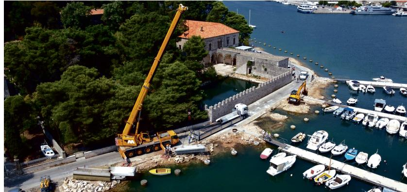
NA PROJEKTU LAPADSKE OBALE započela je faza montaže armirano betonskih elemenata obalnog zida. Na prethodno izvedene armirano-betonske pilote, njih ukupno 131, se ugraduje najprije horizontalni element te se potom na
