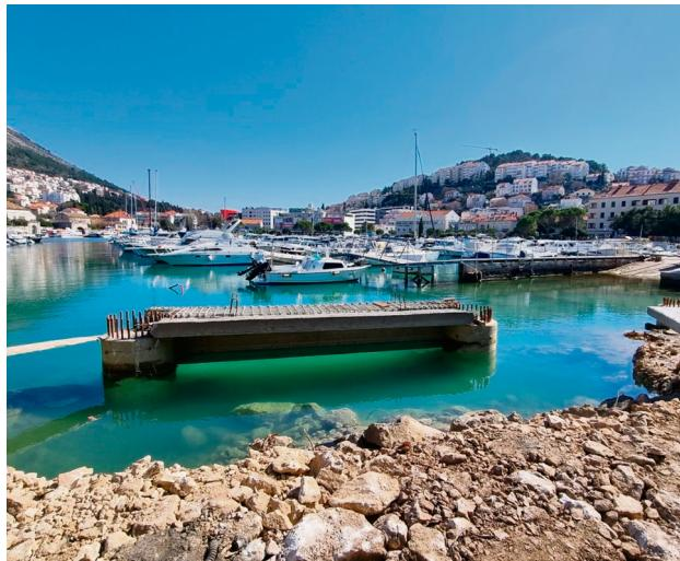
U SKLOPU RADOVA REKONSTRUKCIJE i proširenja Lapadske obale u tijeku je vrlo zahtjevna izgradnja obalnog zida. Montiraju se prethodno betonirani segmenti armiranobetonskih zavjesa, od kojih je prvi postavljen u petak, a planira se postaviti i prvi vertikalni segment. Ovi radovi će napredovati od Batale prema Fakultetu i trajat će do ljeta, a paralelno će se izvoditi i preostali piloti, koji bi trebali biti pobijeni u idućih mjesec dana. Riječ je o izuzetno složenim radovima koji se izvode uz
